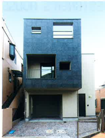
■外壁/前面一部タイル(イタリア輸入)
